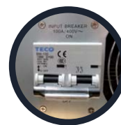
Breaker de entrada
